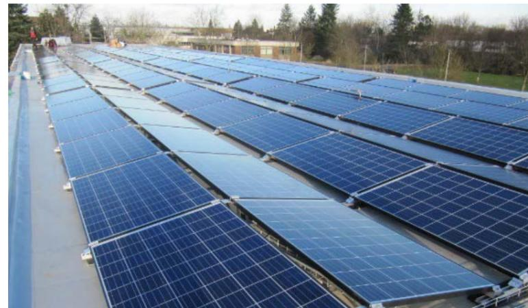
Abbildung 2: PV-Anlage in Ost-West-Ausrichtung
