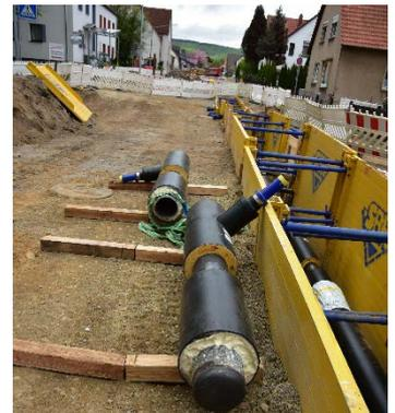
Vorgefertigte Formteile am Rohrgraben für das neue Fernwärmenetz in der Stadt Springe
